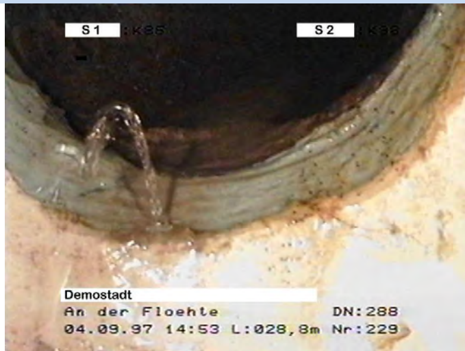
Undichtheiten (Exfiltration/Infiltration)
