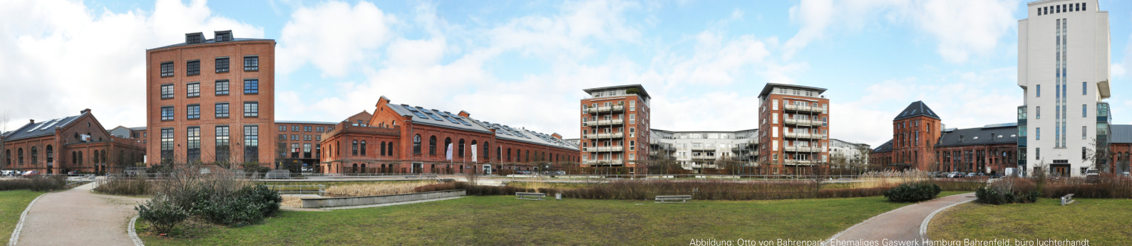
Abbildung: Otto von Bahrenpark, Ehemaliges Gaswerk Hamburg Bahrenfeld, büro lucherhandt
