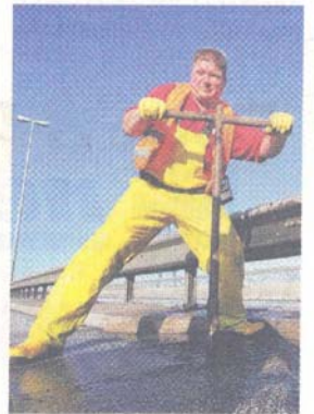
Anders als sonst üblich sind die Gullys auf der Brücke massiv verriegelt.
