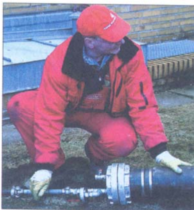
Mitarbeiter der Canal-Control Rohrsanierung GmbH
