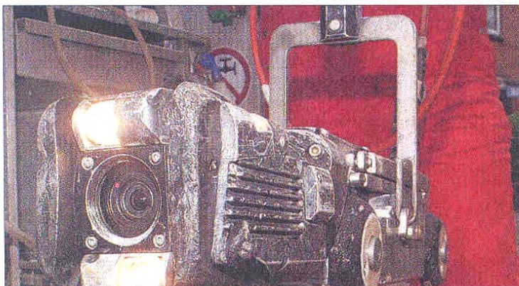
Mit ferngesteuerten Kameras, die durch die Rohre rollen, lassen sich undichte Stellen in Abwasserrohren aufspüren. Foto: Jann
